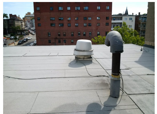
Exhaust fan on roof
